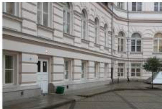
Pochylnia umożliwiająca znalezienie się na poziomie krawężnika
