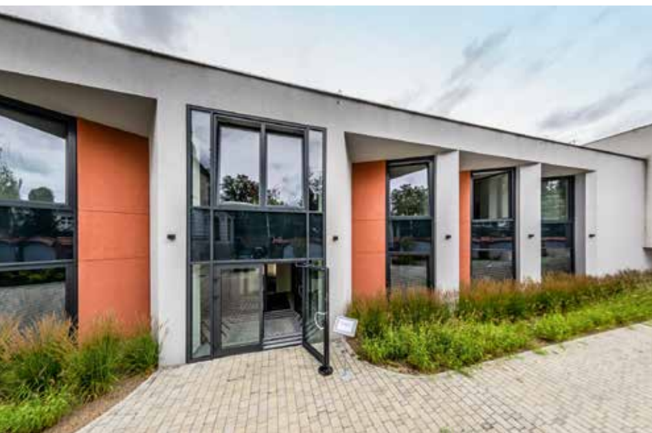
Budynek kolegium tłumaczy w Krakowie
